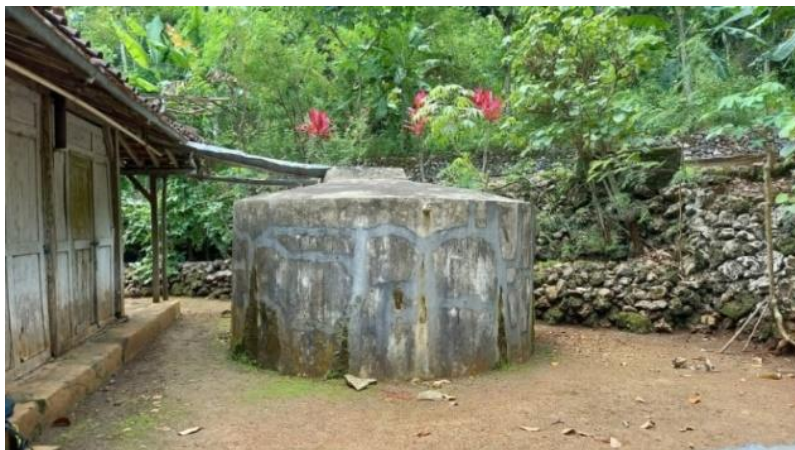
Gambar 1. Penampungan Air Hujan Kapasitas 6000 liter
