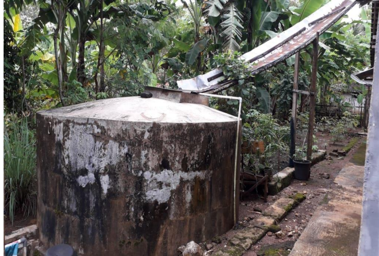
Gambar 3. Kondisi Talang Permanen Air Hujan.
